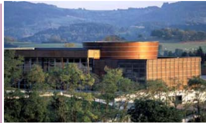
Dompierre les Ormes Galerie Européenne de la forêt et du bois 320 kW
