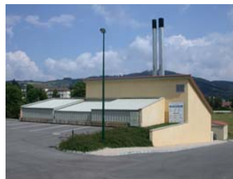
Tramayes Chaufferie collective avec réseau 1200 kW
