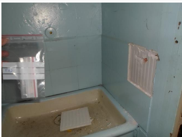
Composant : Colles des carrelages 18 (N) Colle de faïence Pièce 3a
