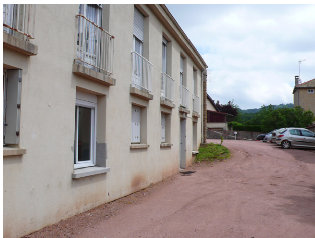
Le côté sud du bâtiment 1950 et le dénivelé du terrain
