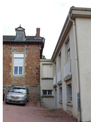
Le raccordement entre les bâtiments XIX e s. et 1950, à l'ouest
