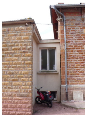
Le raccordement entre les bâtiments XIX e s. et 1950, à l'est
