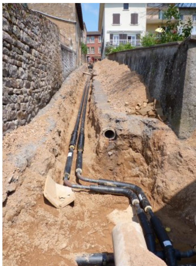
Travaux d'extension du réseau en 2013, photo FD
