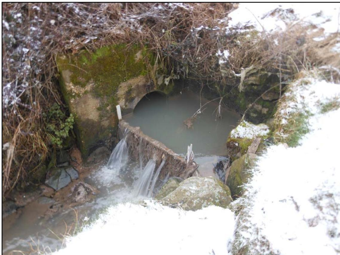
Photo du dégrilleur : la grille est totalement bouchée.
