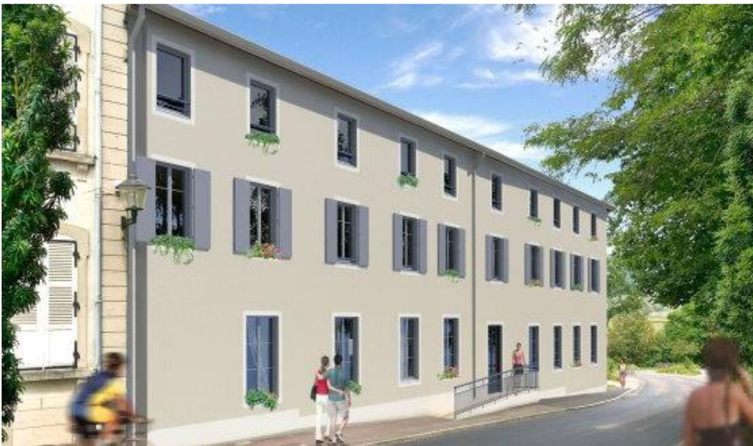
Les ouvertures conservent leurs tailles et positionnements d'origine ce qui ne serait pas le cas avec une isolation intérieure. En effet avec ce dernier dispositif constructif, pour limiter les effets de ponts thermiques au niveau des embrasements des ouvrants, il est nécessaire de les recouvrir d'un isolant ce qui diminuent les côtes tableau.
