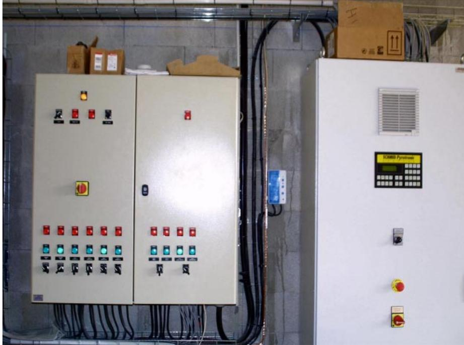
Les armoires de commandes abritent les automates de régulation. Ces derniers assurent le passage automatique d'une chaudière à une autre et surtout commandent les vannes de régulation des circuits de chauffage. D'autre part un petit ordinateur de bord permet de connaître à tout instant les différents paramètres de fonctionnement de l'installation. En cas de problème, une alerte téléphonique est automatiquement déclenchée.
