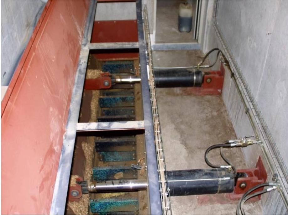
Cette photo représente les vérins qui commandent les mouvements va et vient des grands râteaux ainsi que la chaîne d'alimentation de la chaudière.
