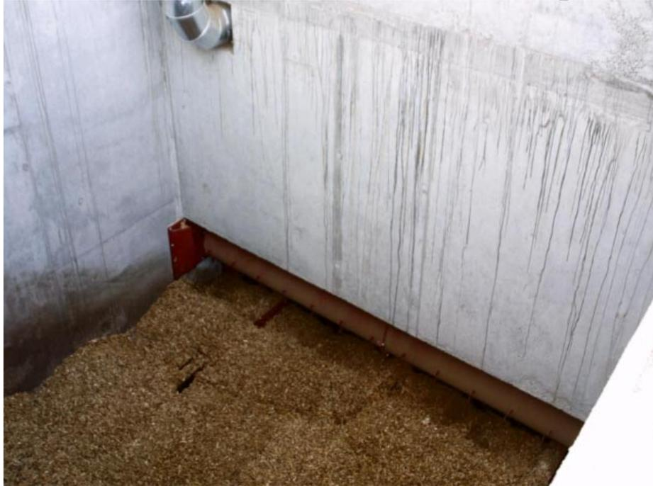
Les grands râteaux raclent le fonds du silo en faisant des mouvements va et vient. Ils sont commandés par l'automate en fonction de la demande en chaleur des usagers. Le bois déchiqueté tombe alors dans le tapis d'alimentation de la chaudière.
