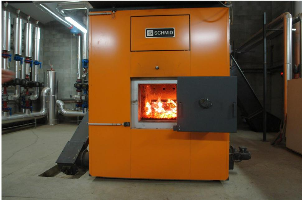
La chaudière prends une place importante et centrale dans la chaufferie. Les tuyaux de raccordement sont isolés thermiquement pour éviter les déperditions thermiques et favoriser un bon rendement.
