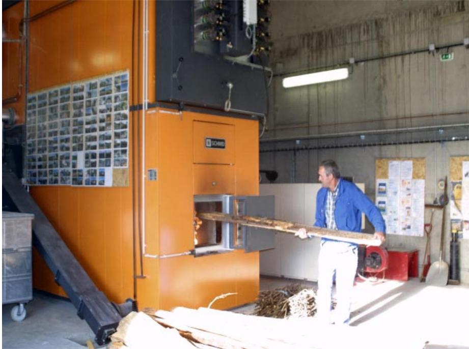
Lors de la première mise en chauffe annuelle, il faut faire un feu de manière traditionnelle dans le foyer pour assurer une montée en température de l'ensemble. Lorsque les capteurs détectent la présence de la flamme, l'automatisme prend alors le relais et l'alimentation régulière du foyer est assurée.
