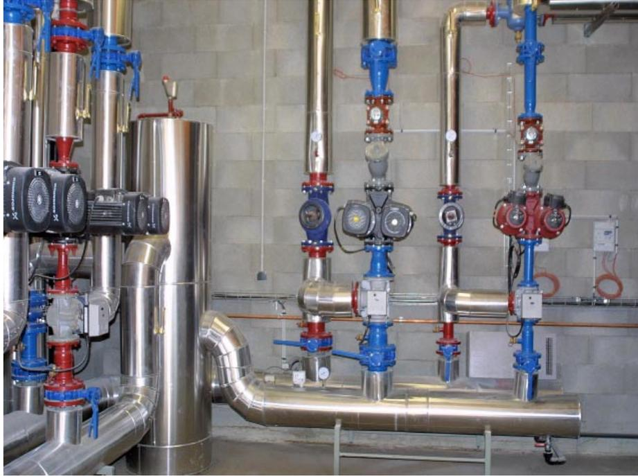
Les pompes de circulation assurent le transfert de l'eau chaude dans les circuits. Chez l'utilisateur un échangeur assure le transfert de l'énergie calorifique vers le circuit de chauffage. Les pompes sont doublées afin de sécuriser l'installation.
