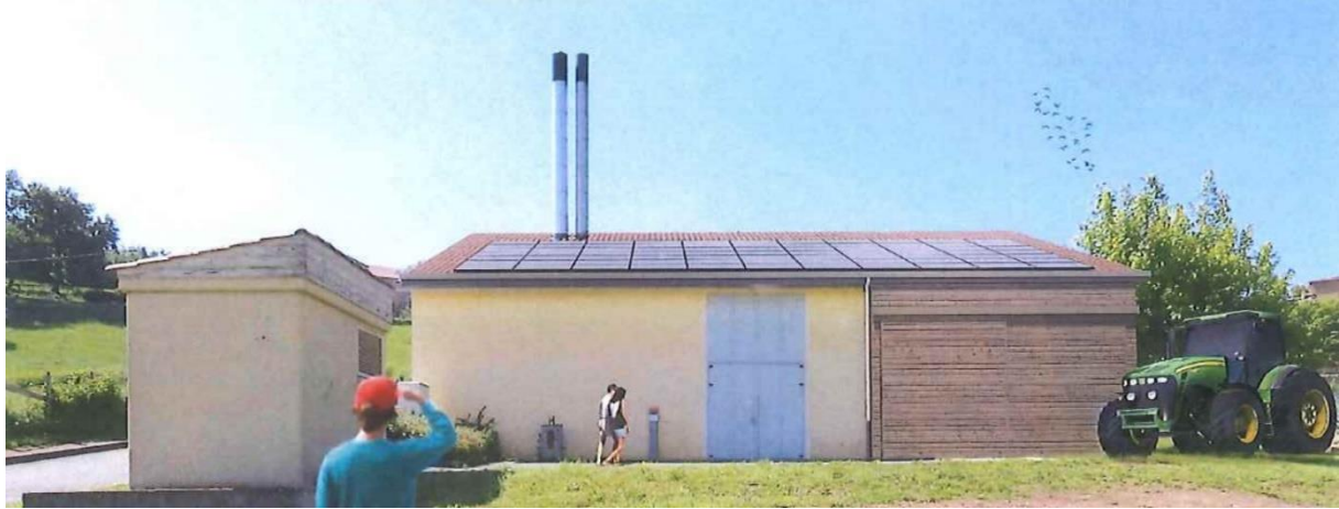
Agrandissement de la chaufferie pour local de stockage et toiture en PV de 36 kWc
